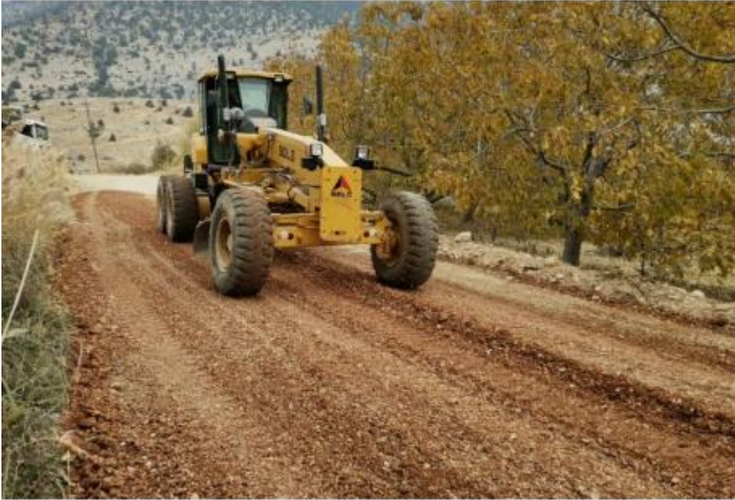
BÜYÜKŞEHİR'DEN 12 MAHALLENİN KULLANDIĞI YOLDA ÇALIŞMA
